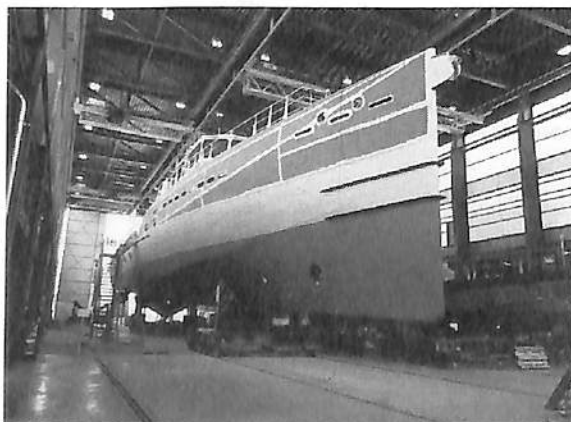
写真 2 ダーメン造船所で建造中の船
