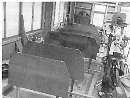
写真7 フレームの取付
