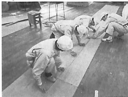
写真6 型板の製作
