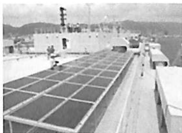
【②甲板上の太陽電池】
