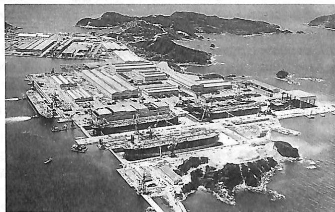
▲写真3 三菱重工業(株)長崎造船所 香焼工場(1972年竣工当時)
