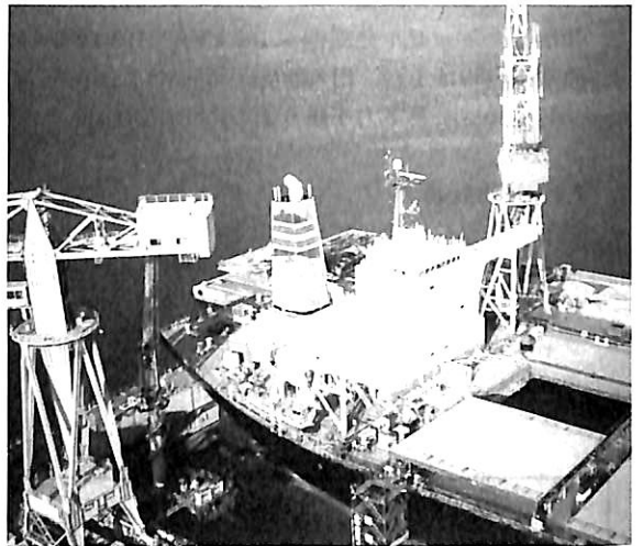
▲ フライングブリッジの取付け
