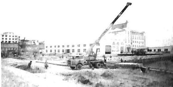
▲ 威海竹内FRP造船所（上下架装置を建設中）
