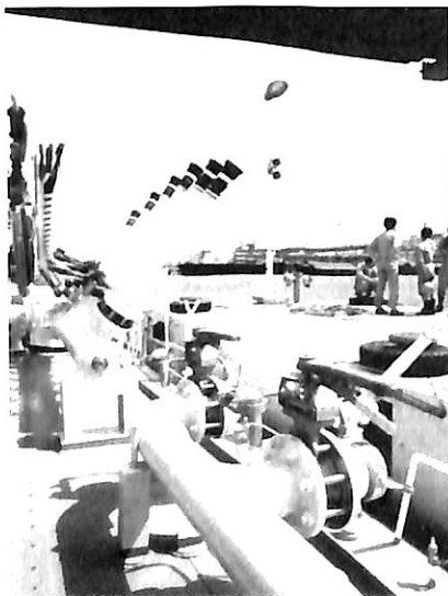
▲ 放水集合管装置
