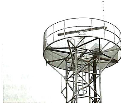
▲ 大型鉄塔頂部に取り付けられたレーダーアンテナ
