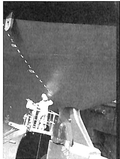
▲ 外板塗装後の Inspection (検査)
