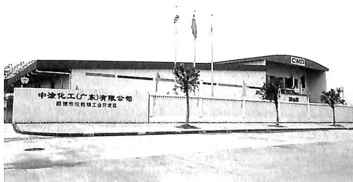
▲ 完成した中塗化工（広東）有限公司と正面
