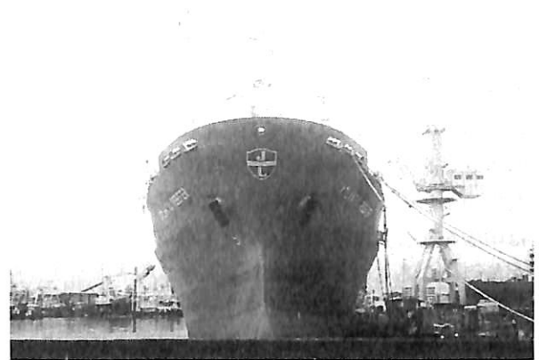
▲ 最終艤装中の本船を船首より見る
