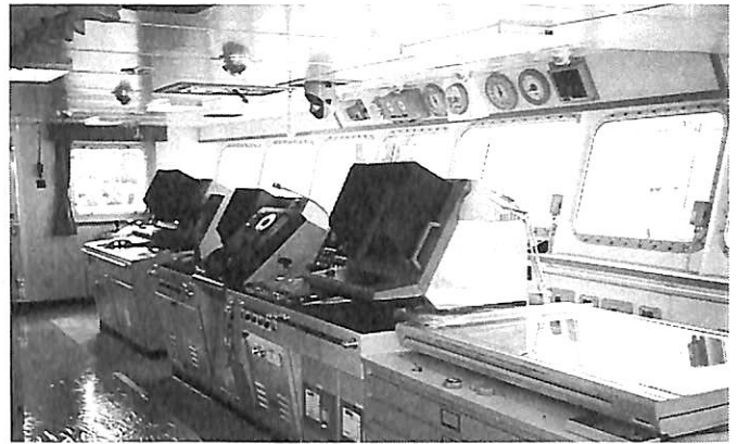
▲ 操舵室(中央部操船コンソール)
