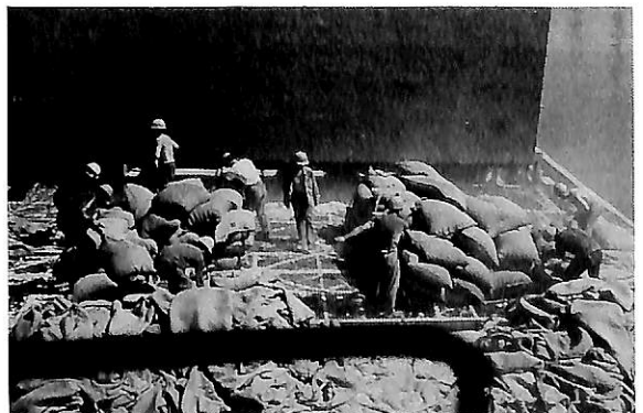
▲ トウモロコシを船艙(ホールド)に搬入(バラ積)する作業
