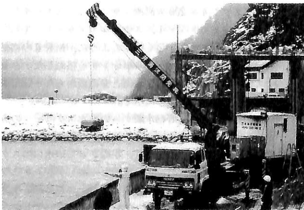
▲ 図23-4 高瀬ダム(長野県)の水面に下されるMURS-300 MK II(1985年11月)
