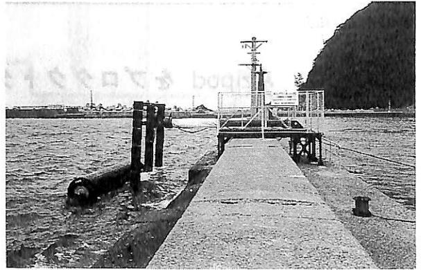
平成8年4月には20トン型作業船の衝突速度，衝突角度を種々変えて本施設に衝突・接触させる実験を行い，衝突速度5ノットでも充分な低反力・大エネルギー吸収機能（最大反力10tf以下，最大吸収エネルギー20tf・m）と斜めに衝突する場合の接触・変針機能の確認を行った。
