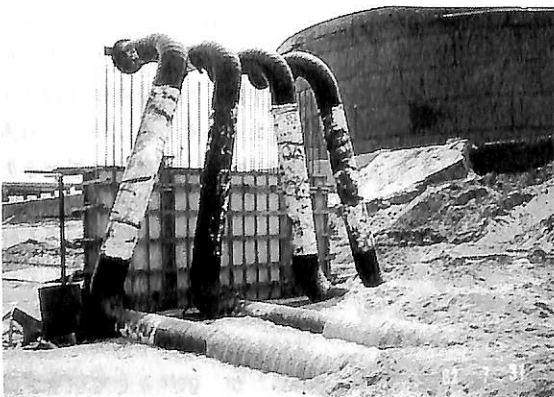
▲図21-12 取り付け終った陸上ライザー管
