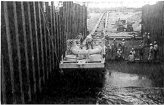
▲ 図 21-9 進水路を海側から見る。(PLEMと2本のパイプラインが結合され、沖合に曳き出される。)
