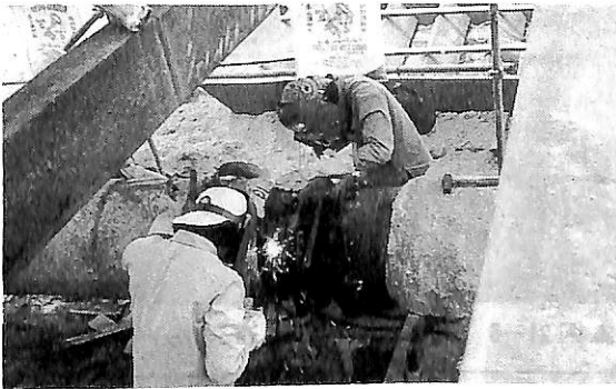
▲ 図 21-3 単管の熔接
