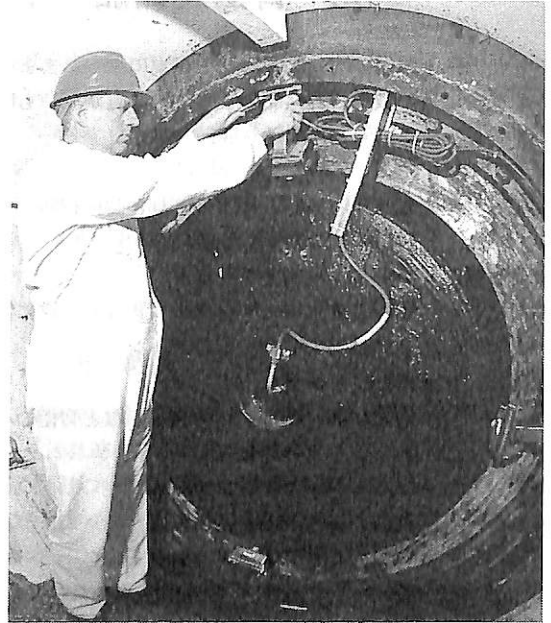
▲ 写真(B) コンディション・モニタリング装置の取付け
