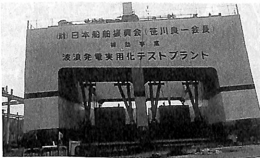
▲ 図 19-3 建造完了し、船尾側から見た海陽。浮体とリンク装置が見える。
