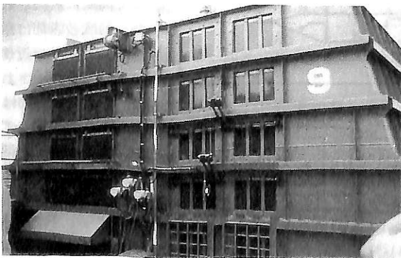
▲ 図18-8 No.9発電機(4枚弁)、内開きと外開きの板弁が見える。
