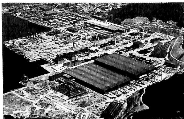
▲写真6 三星重工巨済造船所, 手前が新設ドック (640m×97.5m×13m, 450tクレーン2基) 三星重工パンフレットより
