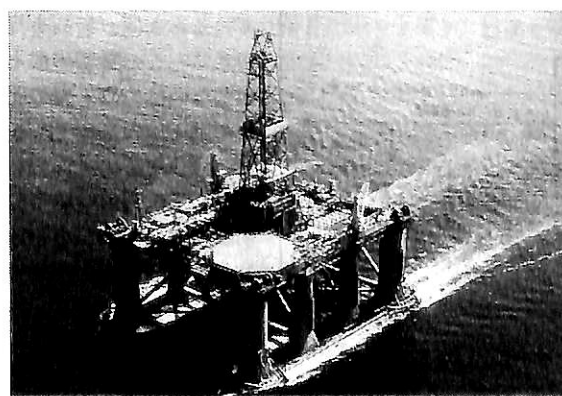
▲ 図-193 試運転中の“Borgila Dolphin”
