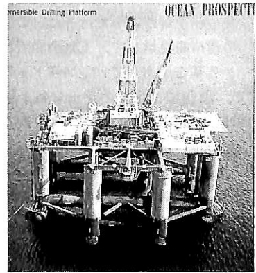
▲ 図-181 半潜水式リグ“OCEAN PROSPECTOR” (三菱重工、AKER造船所が建造に苦労した)
