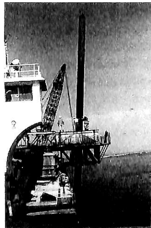
▲ 図-162 “MODEC-250”による掘削状況 (No.2)
