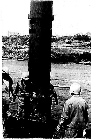
▲ 図-170 掘削パイプ挿入
