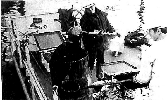
▲ 図-145 回収した油をひしゃくでドラム缶に移送
