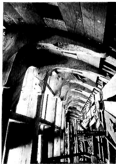
④ 梁曲材(根曲材)の取付
