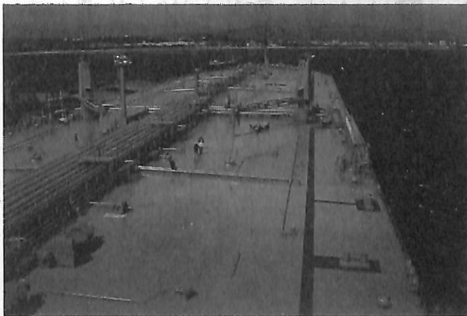
▲ 上甲板配管状況船首方向を見る
