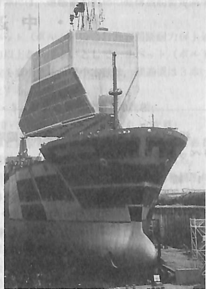
▲ SPB(自立角型)方式LNGタンク
