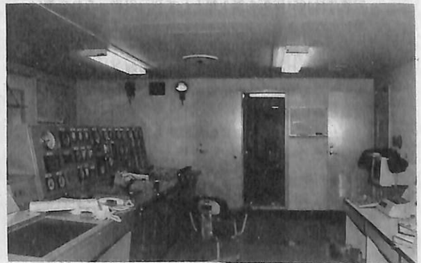
▲ 機関制御室 奥に荷役制御室がある
