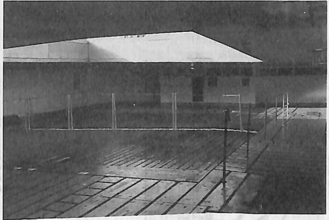
▲トランクデッキ冷凍倉内(デッキクリアー高さ2.30 mを確保)
