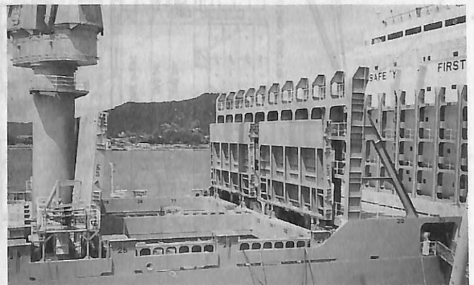
▲ コンテナセルガイド(ブリッジフロント部)
