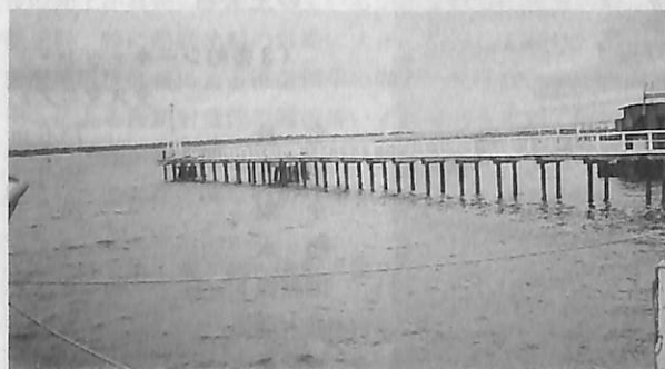
▲ 栈橋（85m・本土側）
