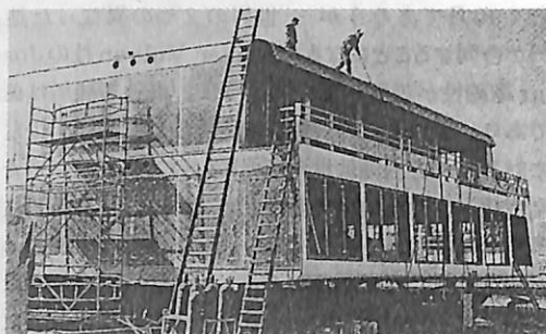
▲ Lloyd Werftは改造期間を最短にするため、Norwayに取付けるモジュールを前もって製作した。写真は48個のプレハブユニット中の一つ。
