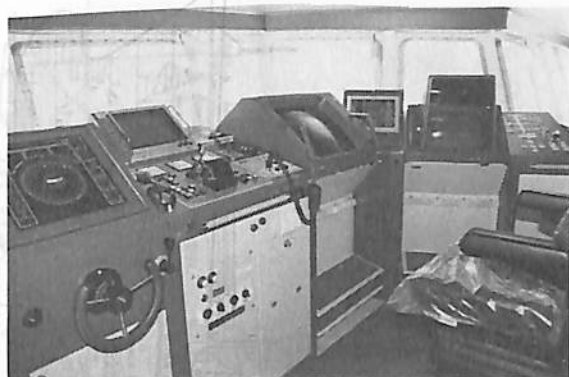
▲ 操舵室のリモコン装置
