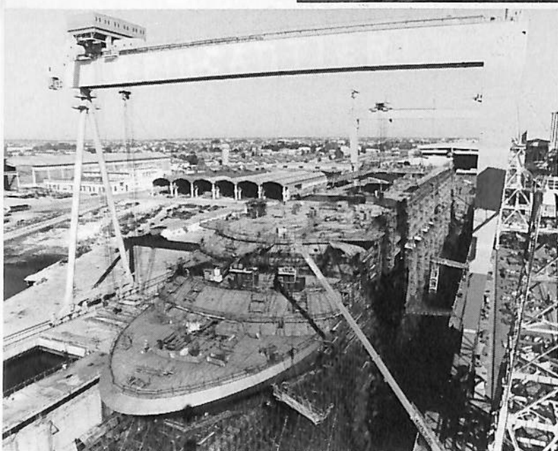
◀ ドライドック内における九分どおりの 船殻工事の進捗状況
