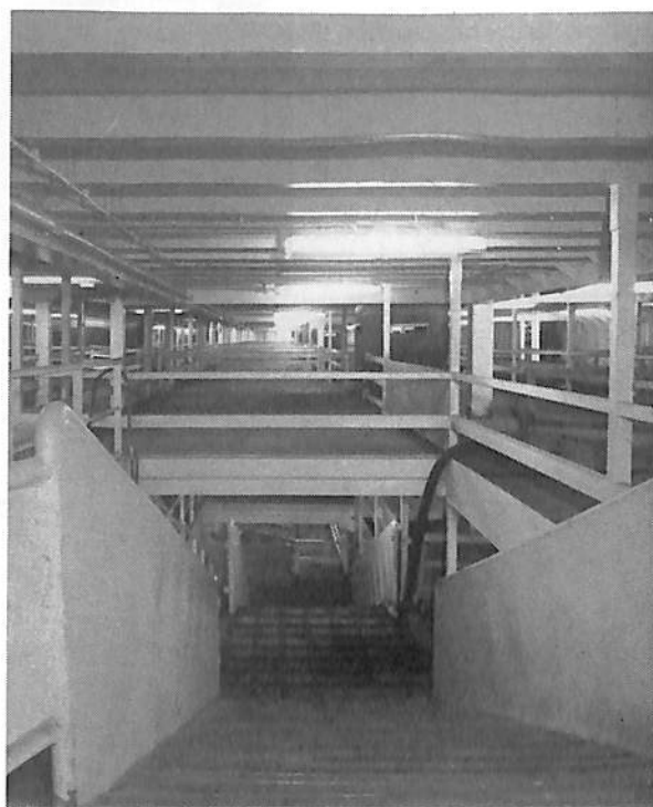
▲ 従来の車輜甲板がそのまま、ライブストックスペースとなっており、デッキ間移動の通路は動物のすべり止めが施されている。
