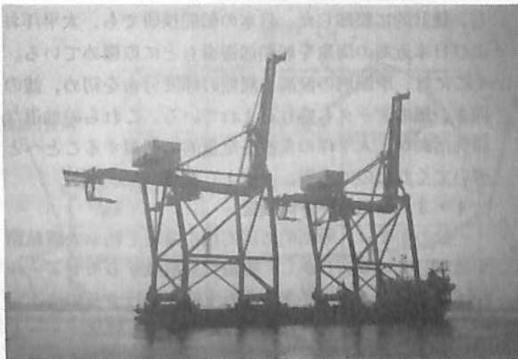
写真 1 重量 1,000t、高さ 100m のコンテナクレーン
