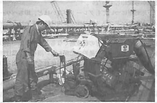
写真4 床面用ブラスト機
