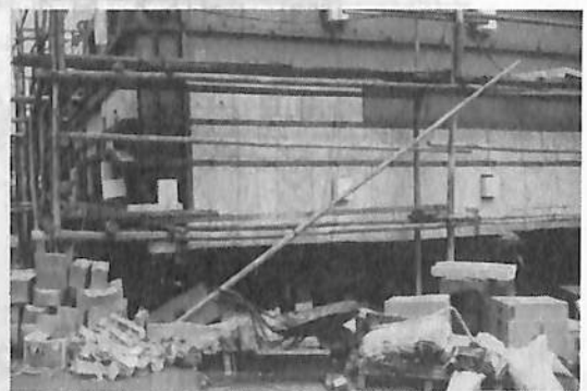
アスファルトタンク周囲の防熱工事
