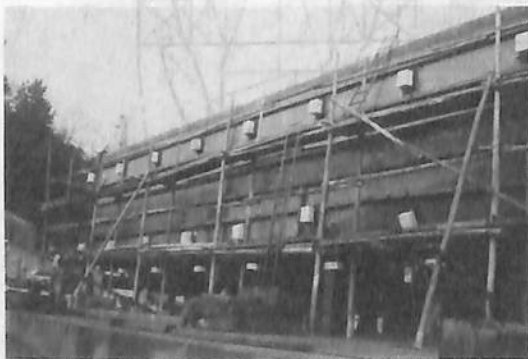
アスファルトタンク（支持ブロック取付、白色の直方体）
