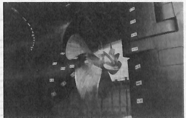
Fig 23 PBCFの実船への装着(まあきゅりいえーす)
