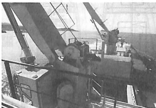
上甲板とデッキクレーン 12.5T (手前), 30T (先方)
