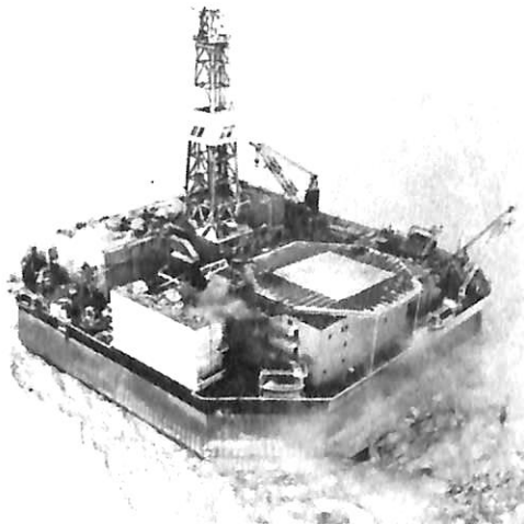
第1図 北極海用移動式人工島型石油掘削装置 “MOLIKPAQ”
