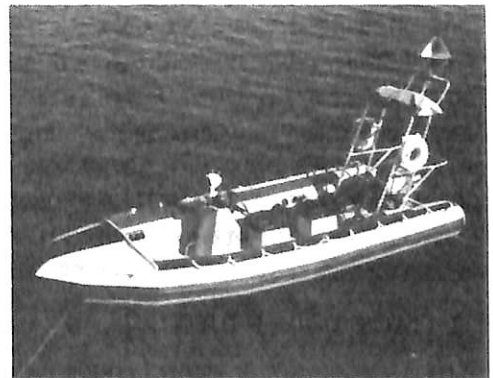
HB-490RS艇尾のヤグラは復正装置、上にレーダーリフレクター、操舵席以外の席は現在ベンチに変わった。
