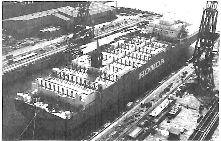
暴露甲板のセルガイド取付状況
