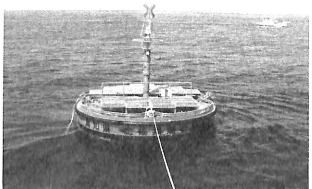
写真2 重防食平行線ケーブルを繫留索とした土佐黒潮牧場1号(浮魚礁)
