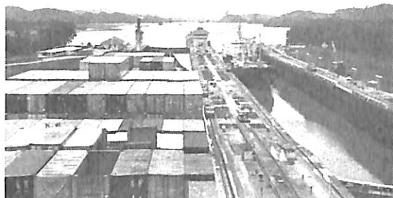
写真6 ベドロ・ミゲル水門を通過中
