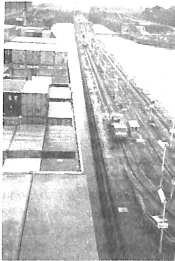
写真1 通過中のガツン水門
