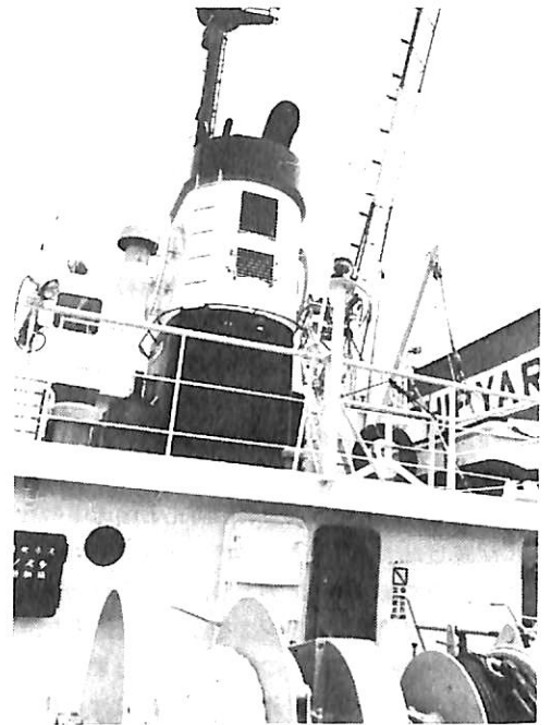
寺岡方式のスパークアレスターを取付けられた煙管とその周辺
