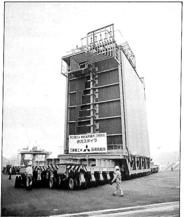
排ガスボイラモジュールを運ぶユニットドーリ
