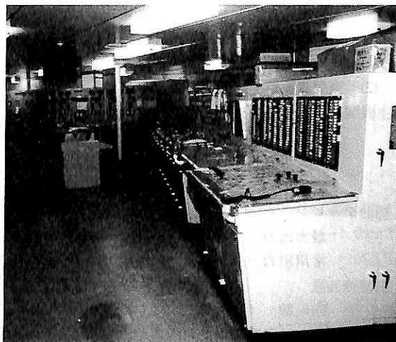
貨物および機関制御室
