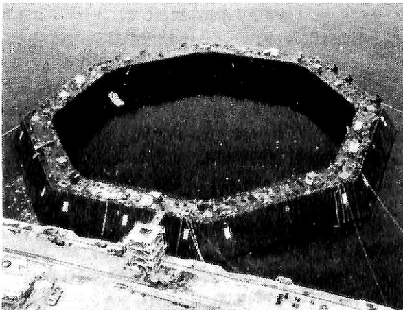
機装中の北極海石油掘削人工島用ケーソン
