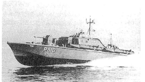
写真7 「Soloven」級デンマーク海軍向けガスタービン魚雷艇 (Vosper 建造)
