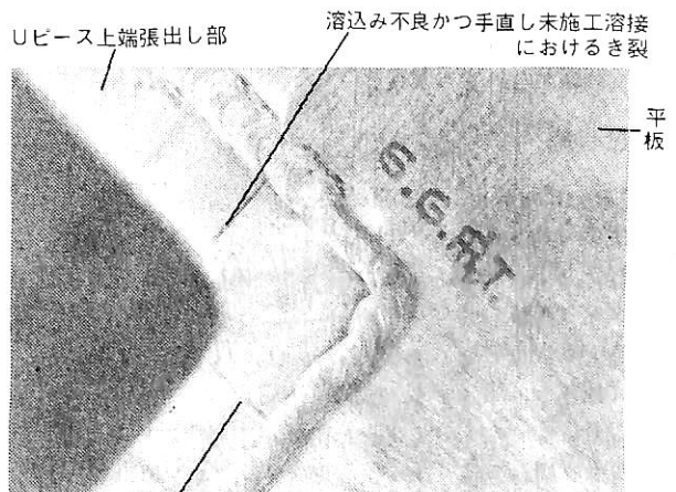
図3 No.6 タンクガスドーム右舷後部
