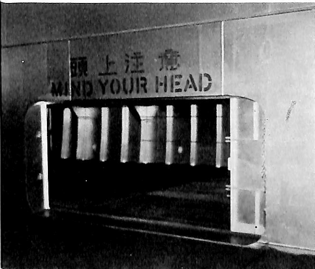
スライディングドア (ホールド内よりカースペースを見る)
