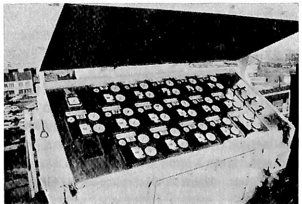
図3・21 ケミカルタンカーの甲板上荷役操作パネル 19)
