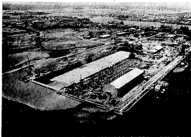
三菱シンガポール重工の造船所(建設時)
