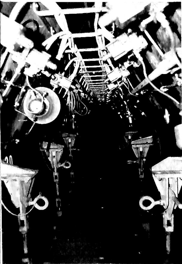
コンベヤスペース
